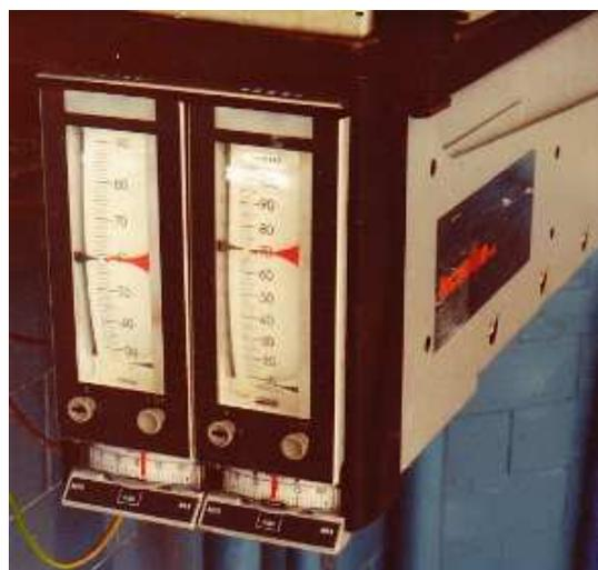
*Figura 15 - Sopra è rappresentato un regolatore master, con registratore<sup>(4)</sup>, in grado di controllare e registrare due variabili. Sotto i regolatori slave, relativi al master detto, che pilotano gli attuatori sulla mandata*
